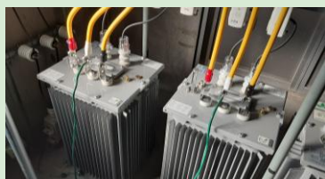
某病院改修工事 変圧器取替工事
