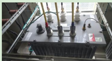
某中学校 変圧器取替工事
